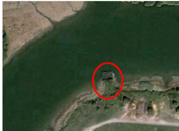
Quai et estacade en bois, vue satellite (2005)
