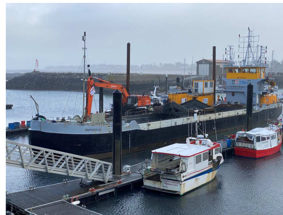
FIGURE 14 : CHARGEMENT PAR PELLE MECANIQUE D'UNE BARGE AUTOPORTEE APPARTENANT A LA SOCIETE MERCERON
