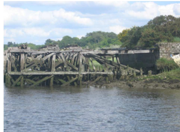
Photographie du quai et de l'estacade (non daté, a priori 2006-2007)
