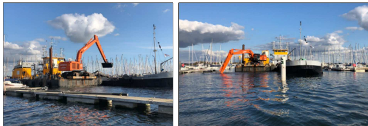
FIGURE 10 : DRAGAGE MECANIQUE PAR PELLE (SOURCE : MERCERON TP, 2020)
